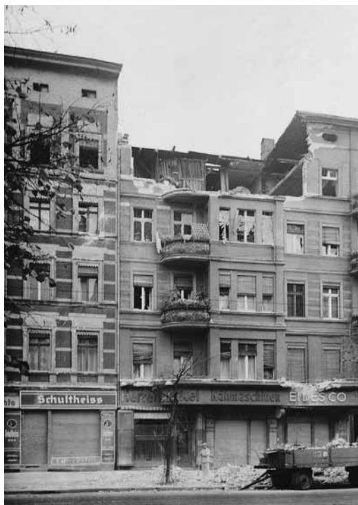
Die Brunnensstraße 84 gehörte zu den ersten von Bomben getroffenen Häusern im heutigen Brunnenviertel (Aufnahme um 1940). Foto: Archiv Berliner Unterwelten e.V.
