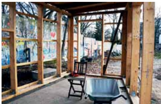
Auf dem Foto oben wird der Bau des Fundaments vorbereitet. Das untere Foto zeigt den fertigen Rohbau. Fotos: Michael Becker
