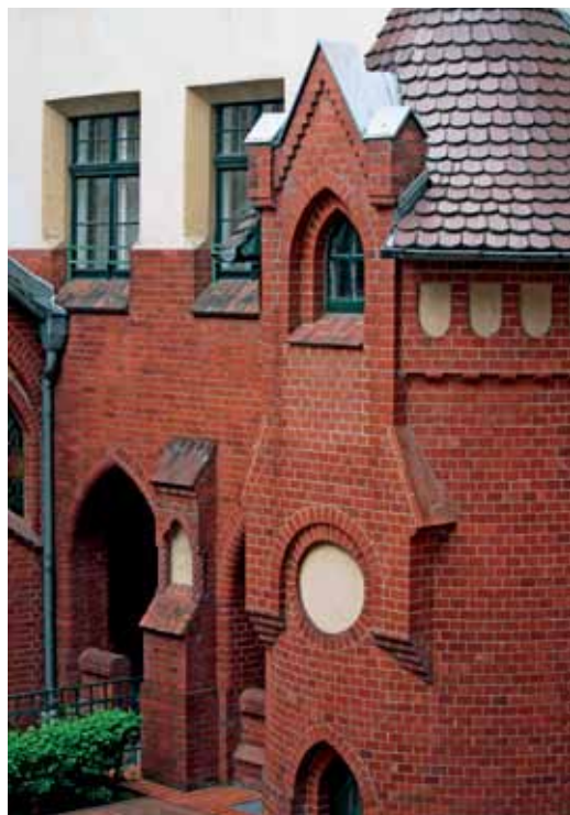
In der Graunstraße 31 befindet sich eine katholische Kirche und ein Wohnhaus. Fotos: Andrei Schnell
