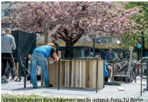
Unter blühenden Kirschbäumen wurde gebaut. Foto: TU Berlin
