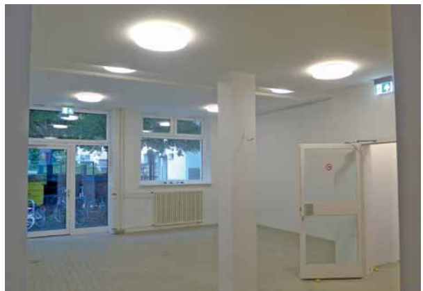
Beleuchtung und Akustikdeckenplatten sind eingebaut – Blick in Richtung des zweiten Fluchtwegs. Foto: Beate Heyne
