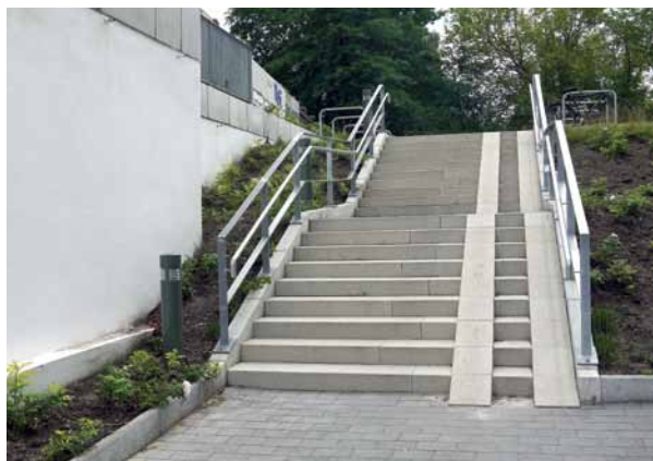
Eher Gefahrenherd als Hilfe: eine neu gebaute, aber unbrauchbare Rampe vor dem Gleimtunnel. Sie ist viel zu steil. Foto: Alexander Koch
