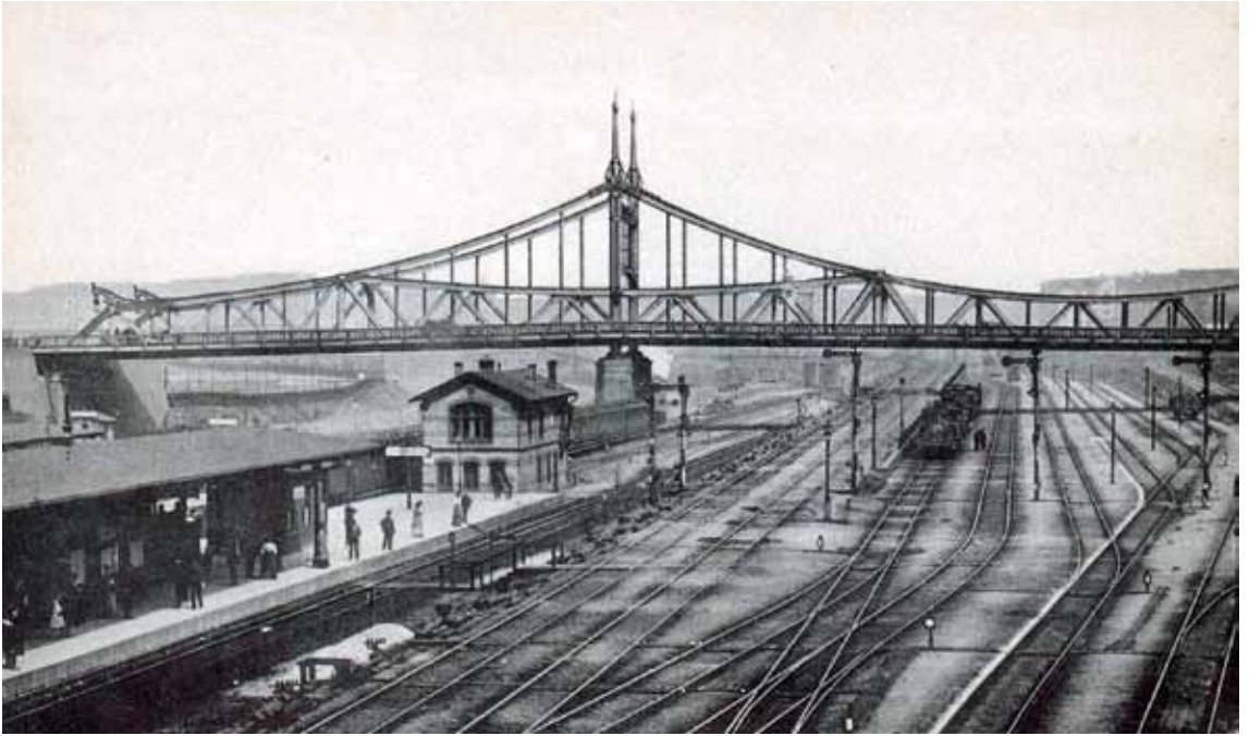
Unter der 1,2 Millionen Mark teuren und mit rund einer Million Nieten erbauten Swinemünder Brücke, daher der Spitzname „Millionenbrücke“, verlaufen in einem Trog die Gleise der Berliner Nordbahn, Berlin-Stettiner Eisenbahn, der Berliner Ringbahn und der Abzweig zum Güterbahnhof der Nordbahn (heute Mauerpark). Links im Bild um 1910 ist der Ringbahnsteig Gesundbrunnen zu sehen.
