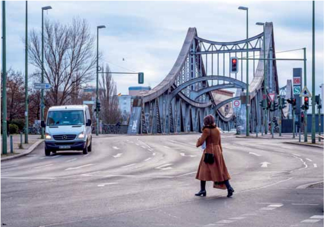
Eine Fußgängerin überquert die Jülicher Straße an der Swinemünder Brücke.
