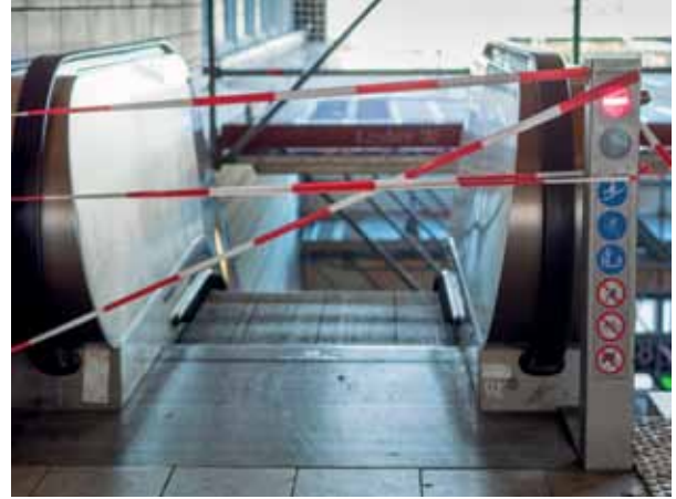
Abgesperrte Rolltreppe am Bahnhof Gesundbrunnen.
