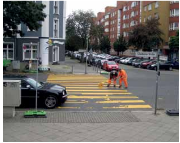
Der provisorische Zebrastreifen wird ausgebessert (2017).
