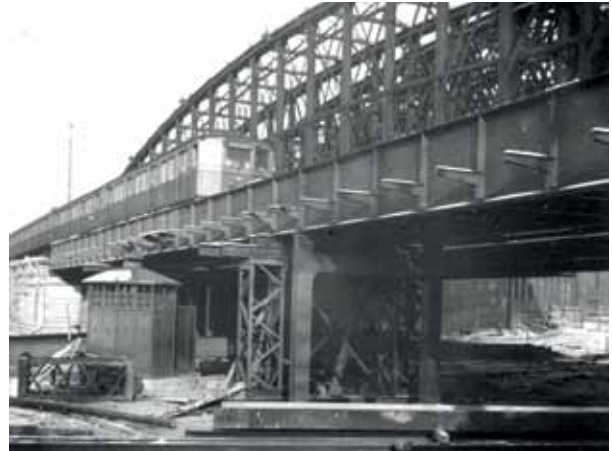
Neubau Liesenbrücke für die S-Bahn (1956).
