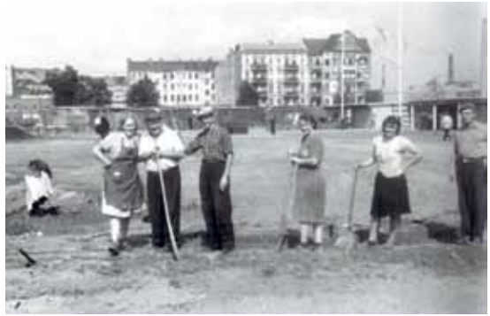
Bau des Schwimmbads 1951. Unter den Notstandsarbeitern waren auch zahlreiche Frauen. Foto: Sammlung Ralf Schmiedecke
