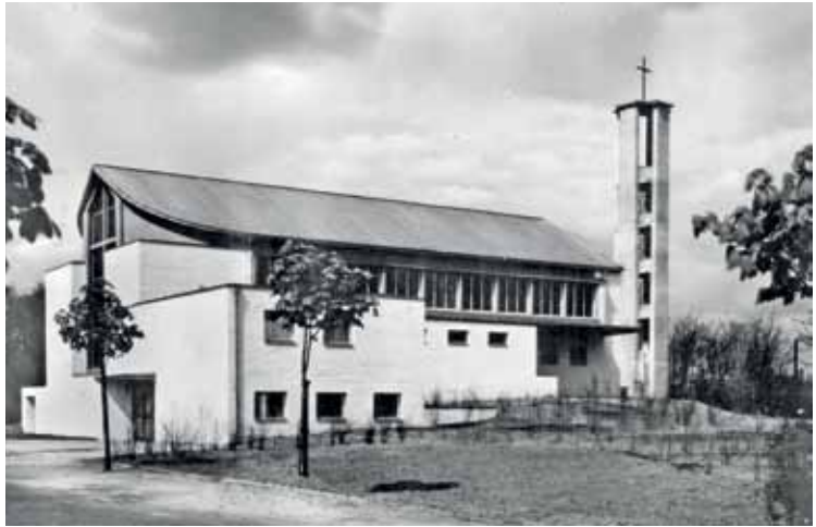
Der Neubau der Himmelfahrtskirche um 1965. Foto: Sammlung Ralf Schmiededecke
